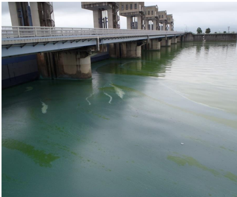
北部排水門でのアオコの発生状況
