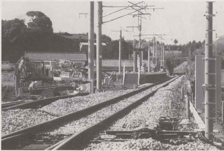
▲急ピッチで工事が進む長里駅
