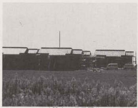
▲建設中の長里団地
