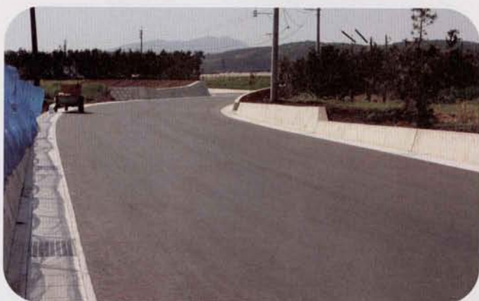
▲町道井崎田原線の拡幅工事
