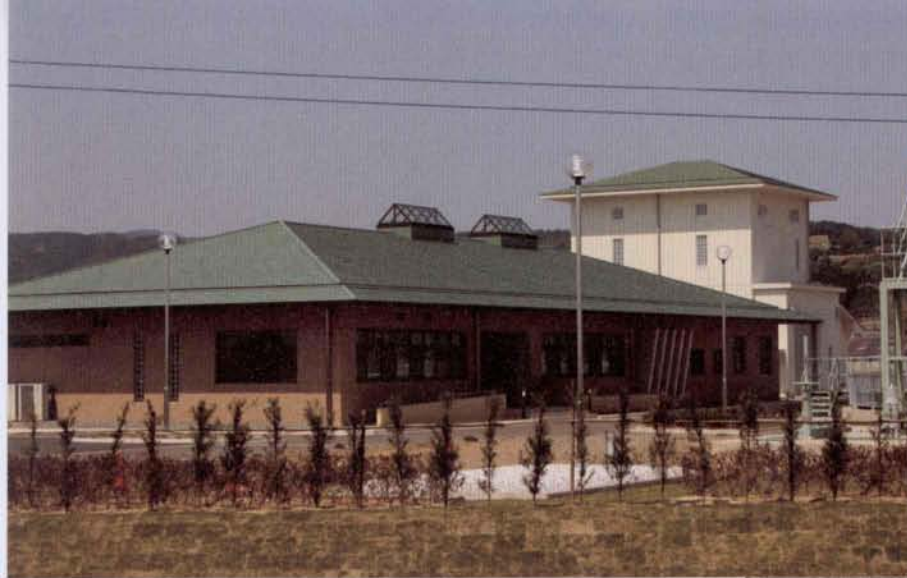
▲下水道処理施設の外構整備(手前)と 汚泥処理棟建設(奥)
