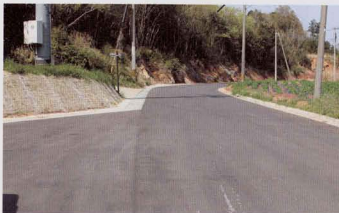
▲町道釜線の拡幅工事
