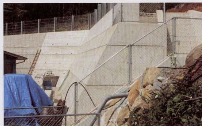
▲風生地区の急傾斜崩壊対策工事
