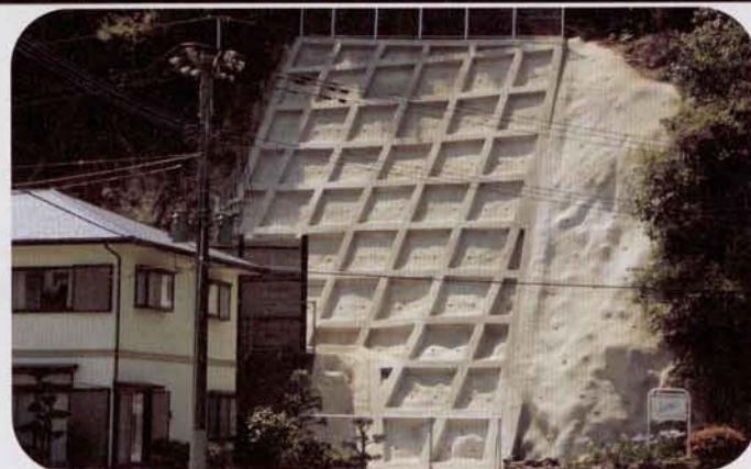
▲丸尾地区の急傾斜崩壊対策工事
