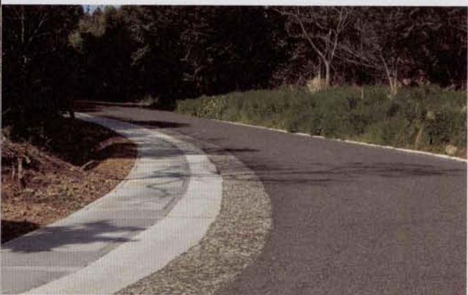
▲町道農場線の拡幅工事
