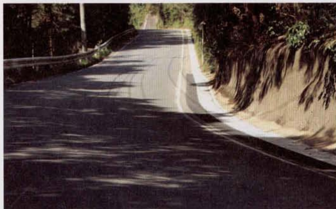
▲町道田原線(旧県道)の側溝整備
