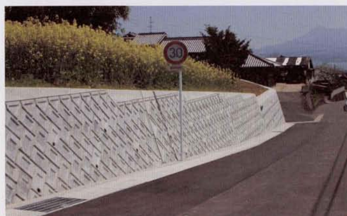
▲町道田代線の拡幅工事
