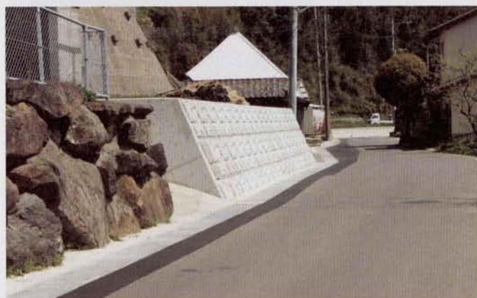
▲町道川内線の拡幅工事
