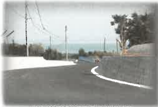
▲町道井崎田原線拡幅
