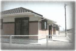
▲町営住宅田代団地建設
