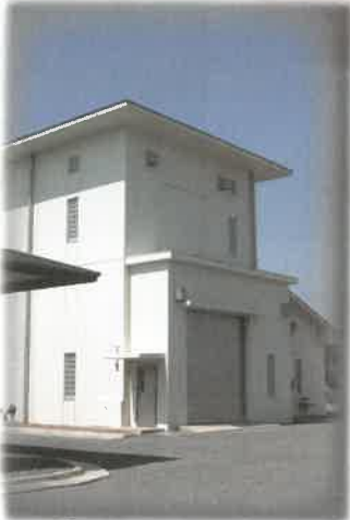
▲下水道汚水処理棟建設
