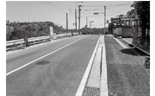
⑨ 市道山川町 1 号線
