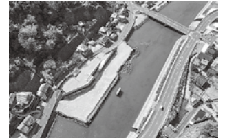
⑤ 市道井樋線 【江ノ浦川総合流域防災事業関連】
