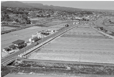
② 国道 207 号【長田工区】
