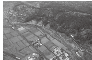
④ 市道赤水線 【本明川ダム事業関連】
