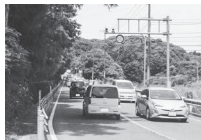
花高入口交差点 付近未改良区間 （下大渡野町）
