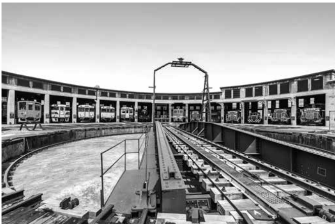
▲旧津山扇形機関車庫
