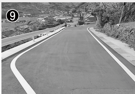
⑨ 市道百石中通線 (道路整備)
