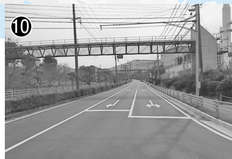
⑩ 市道中核工業団地2号線 (道路整備)
