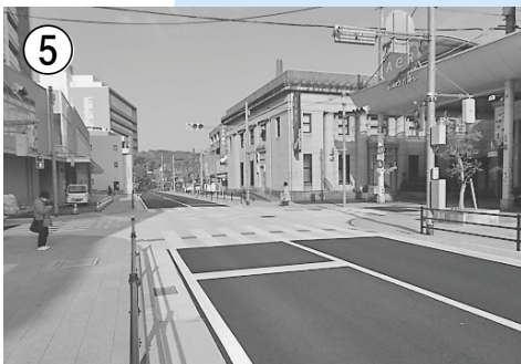
⑤ 県道有喜本諫早停車場線【栄工区】 (歩道整備)
