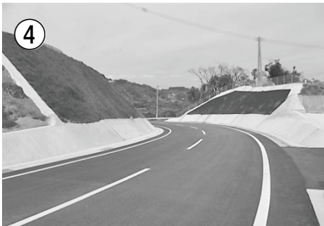
④ 国道207号【佐瀬拡幅】(道路整備)
