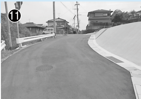
市道有喜町塔の元線 (道路整備)
