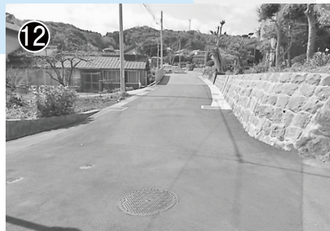
市道下方線 (道路整備)
