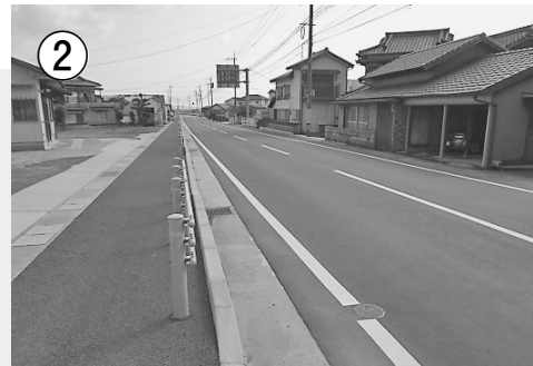
② 国道207号【長田工区】(歩道整備)
