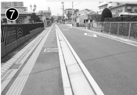
⑦ 市道厚生町仲沖線 (歩道整備)
