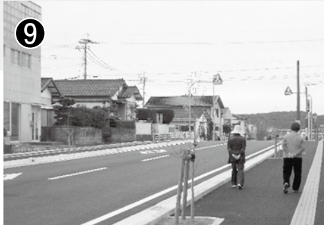
⑨ 市道真崎貝津線 (歩道整備)
