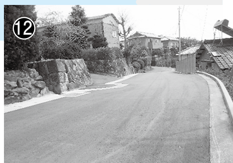
市道下方線（道路整備）
