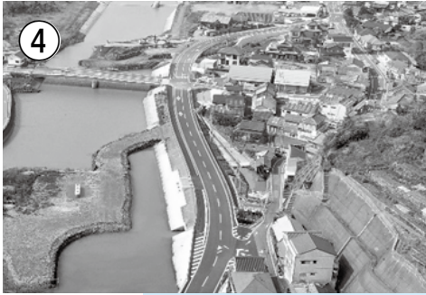
④ 県道諫早飯盛線【江の浦工区】(道路整備)
