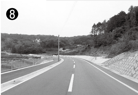
⑧ 市道天神早見線 (歩道整備)
