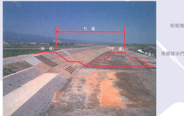
半造川左岸引堤完成状況
