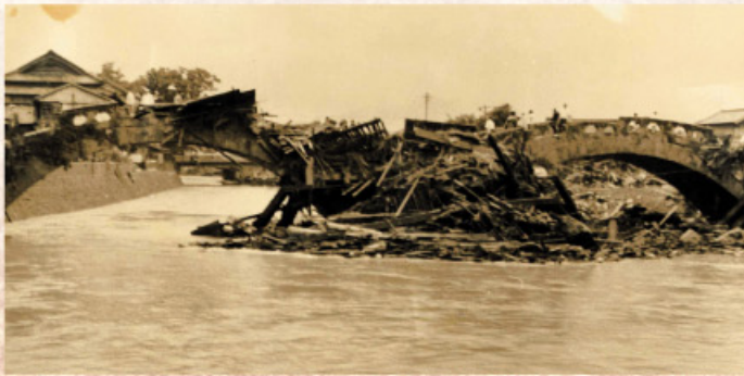
押し寄せた流木をせき止め被害を大きくした眼鏡橋
