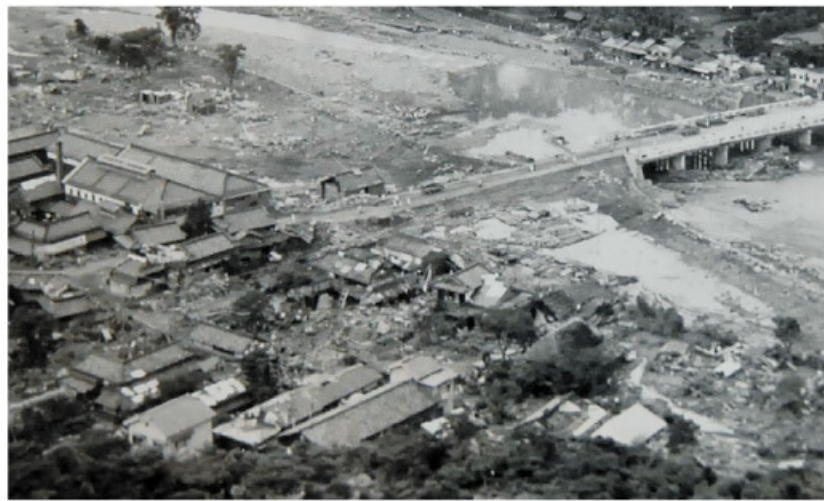
被害2ヵ月後の状況
