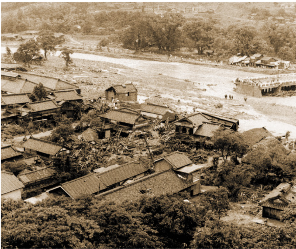
四面橋周辺の水害翌日26日朝撮影
