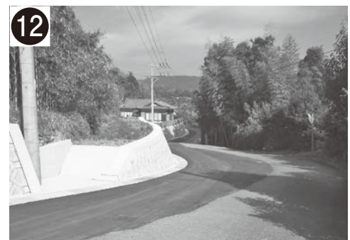
市道城崎船津線 (道路拡幅)
