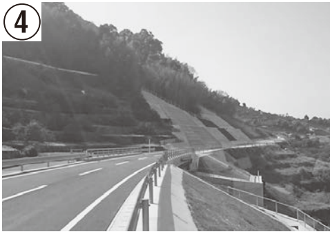
4 国道207号【佐瀬拡幅】(道路拡幅)
