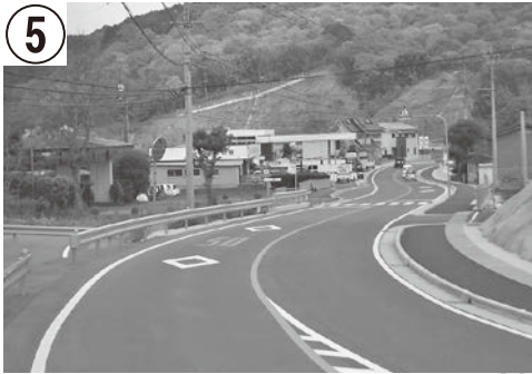
5 県道諫早飯盛線【土師野尾工区】(道路拡幅)
