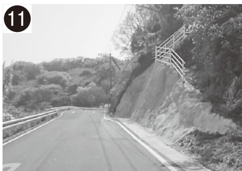
市道大門戸石線 (道路拡幅)
