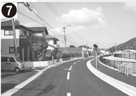
7 市道喜々津駅裏線 (道路拡幅)
