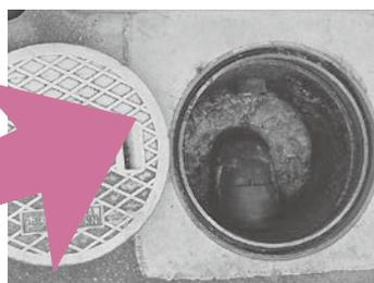
溜めマスの大きさは、直径30～40cm。フタの取っ手を持って、上に引き上げると開閉できます。
