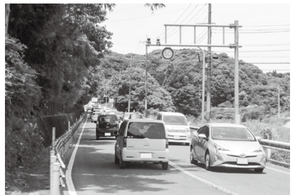
花高入口交差点付近未改良区間（下大渡野町）
