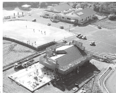
【建設中の有喜・松里地区浄化センター】
