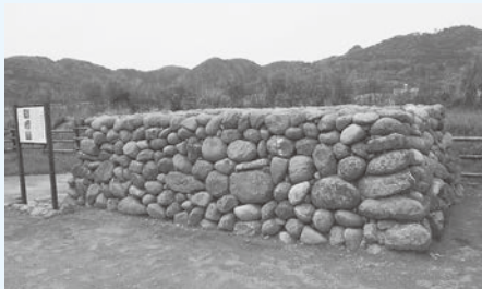
完成した井樋堤塘跡
