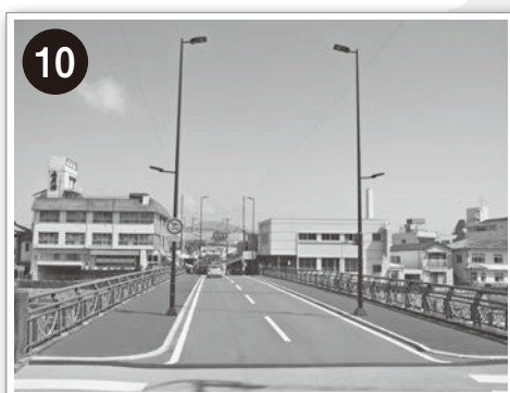
市道八天西郷線 (橋梁長寿命化のための橋面舗装)
