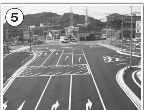
一般国道207号【宇都工区】(交差点改良)
