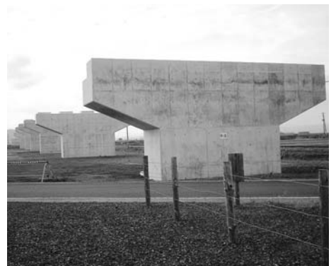
国道57号森山拡幅(田尻高架橋)
