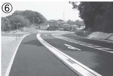
主要地方道諫早飯盛線【新道工区】
