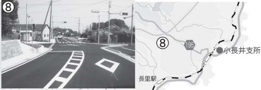
一般県道小長井線【田原工区】
