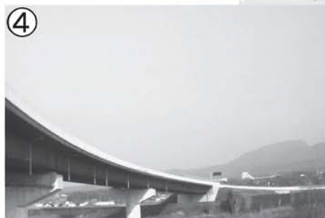
一般国道251号愛野森山バイパス (平成25年12月21日供用開始)
