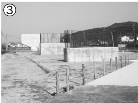
一般国道 57 号森山拡幅【尾崎交差点～田尻 I C】 (国道 57 号の渋滞緩和と高速交通体系の構築を行います)
