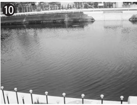
市道化屋木床線 (化屋地区と木床地区をつなぐ歩道橋の整備を行います)
