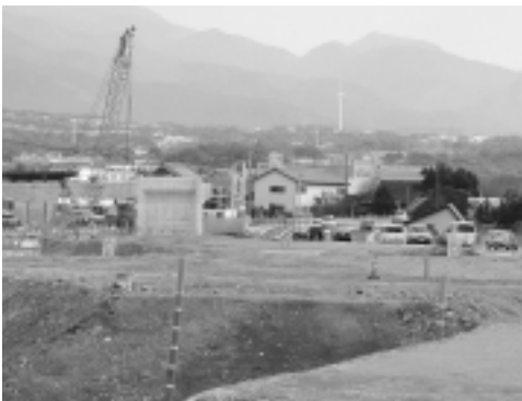
整備が進む「国道251号愛野森山バイパス」
