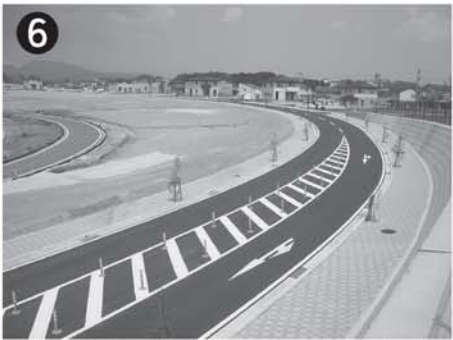
市道西部台1号線 (完成:平成24年3月)
