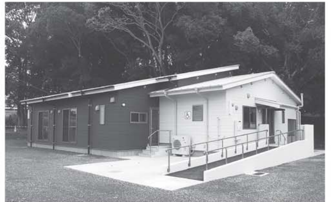
今年2月に完成した御館山小学校区学童クラブ舎
