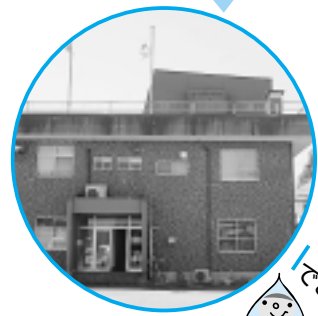
浄水施設 (写真は平山浄水場)
