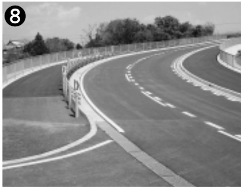
市道天満目代線 完成：平成22年12月
