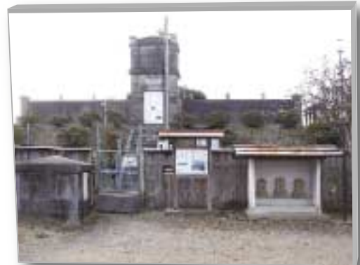
泉配水池（泉町532番地）
