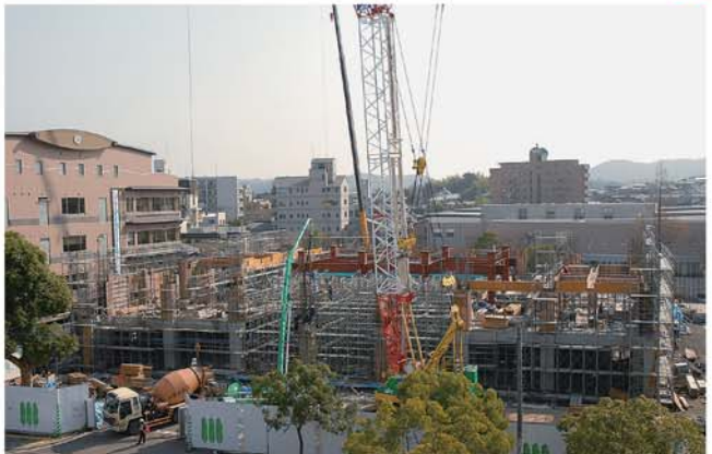
工事が進む新庁舎(平成21年11月末完成予定)
