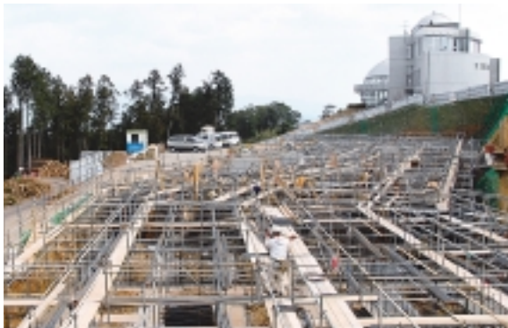
基礎工事の様子
