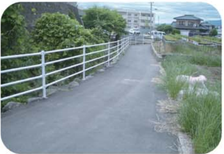
通学路に利用される未舗装道路を整備し、併せて転落防止柵を設け通行の安全を図りました。(小川町)
