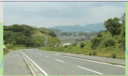
6 市道天満目代線 延長1,291m 新設改良工事
