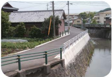
すり鉢状だった道路(護岸)を改良し、通行の安全を図りました。(森山下町下井牟田)
