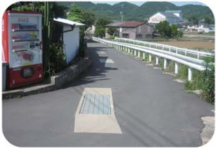
生活道路の側溝修繕や舗装の改修を行い、安全に通行できるようになりました。(飯盛町上原)
