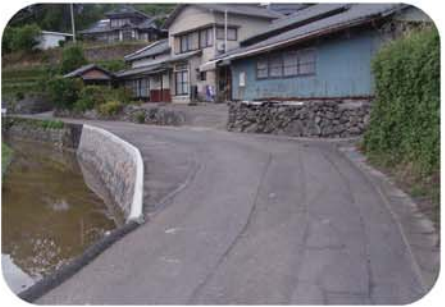
用地協力(寄付)により市道の拡幅改良を行い、より安全に通行できるようになりました。(高来町古場)
