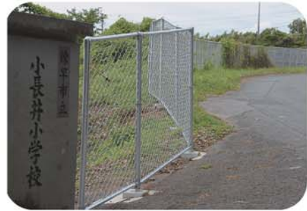
老朽化した金属フェンスの付け替えを行い、通学路の安全を確保しました。(小長井町小川原浦)
