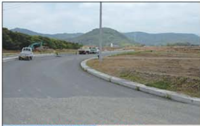
8 市道流通産業団地線 延長1,215m 供用開始予定：平成21年1月
