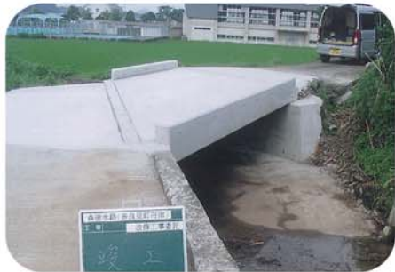
森徳水路の川底の改修や橋の架けかえ工事を行い、通水断面の確保を図りました。(多良見町舟津)
