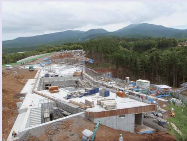
(仮称) こどもの城建設現場 (6月23日撮影) 奥に見えるのは五家原岳
