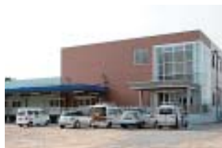
津久葉町に建設中の諫早市西部学校給食センター
