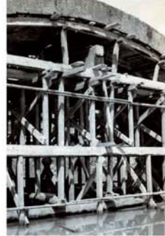
▲国の重要文化財の指定を受け、石橋としては前例のない移設復元の作業が始まった。工事に先だってまず、橋体各部の精密な実測が行われ、構成図面が作成された。さらに全ての石に墨汁で符号・番号が記された。
