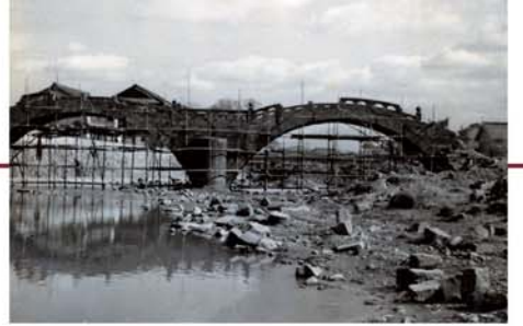
▲国の重要文化財の指定を受け、石橋としては前例のない移設復元の作業が始まった。工事に先だってまず、橋体各部の精密な実測が行われ、構成図面が作成された。さらに全ての石に墨汁で符号・番号が記された。
