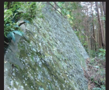
土俵広場を強固なものにした周囲の石垣。しっかりとした堅固な石積みである
