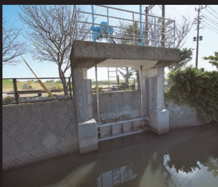
公園そばの水門（水の流れを調整する開閉門）
