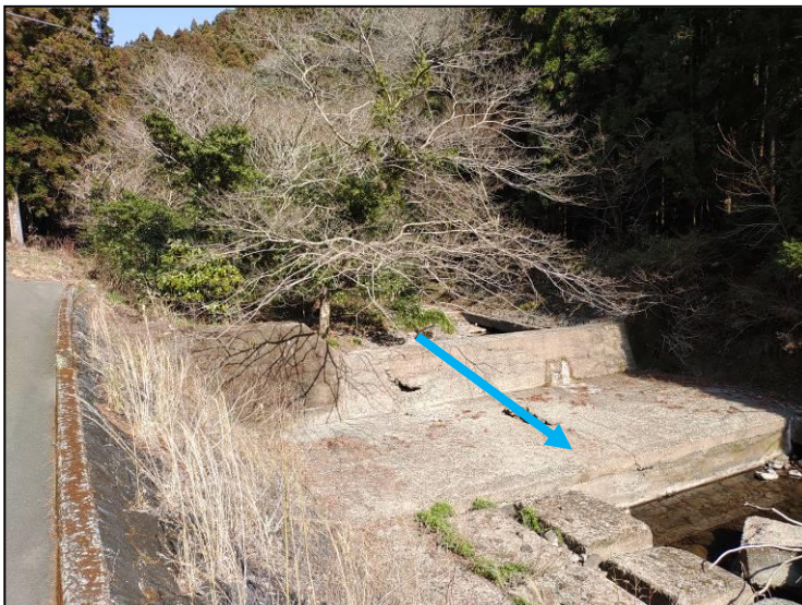
【一級河川本明川水系： 湯之尾川】 大林橋より約180m 上流部の状況
