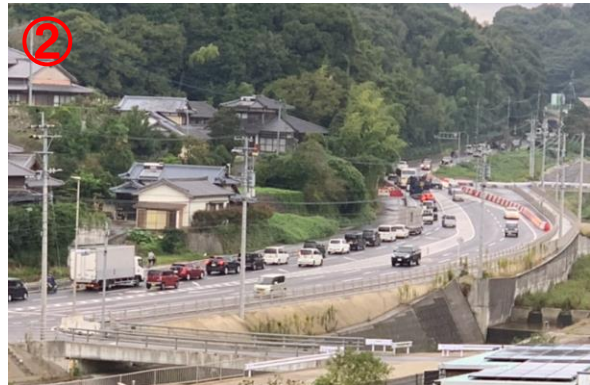
② 混雑状況 (花高入口交差点付近)
