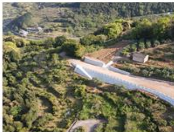
【伊木力第3地区】 (整備状況)
