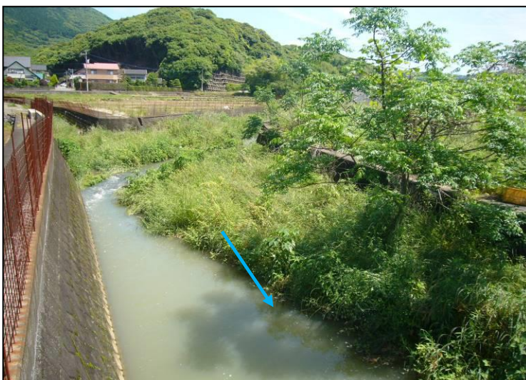
【二級河川：江ノ浦川】 飯盛東小学校より 約 300 m 上流の状況
