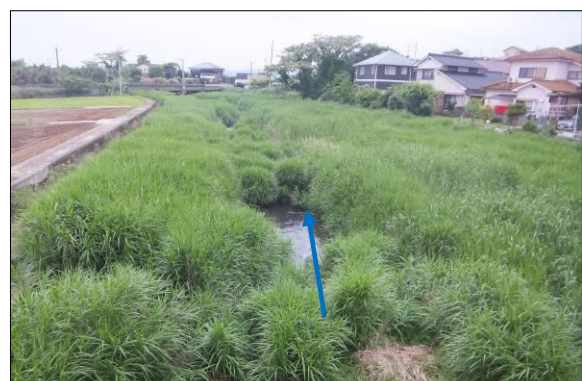
長田川における土砂の堆積、草木の繁茂状況
