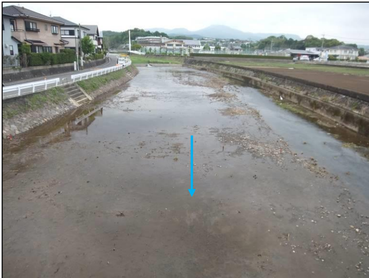
【一級河川本明川水系： 長田川】 浚渫が完了し治水上也も 環境上も良くなった長 田川。長田小学校下流付 近の状況
