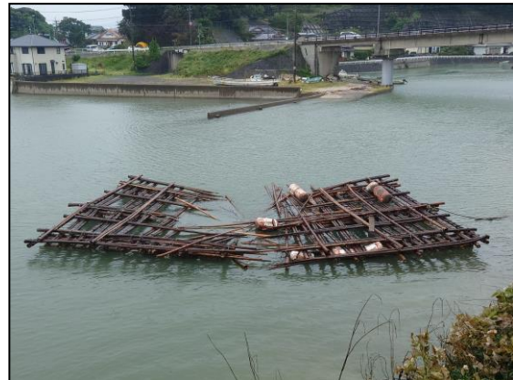
台風によるカキ筏の破損状況
