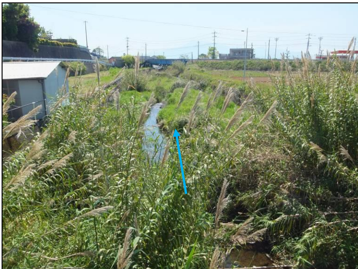
【一級河川本明川水系： 田島川】 暖竹の繁茂が著しい J R 長崎本線上流部の状 況
