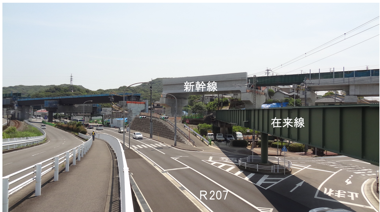
宇都橋りょう工事（諫早市宇都町付近）
