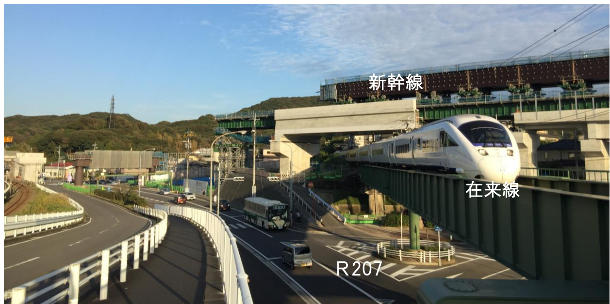
宇都橋りょう工事（諫早市宇都町付近）
