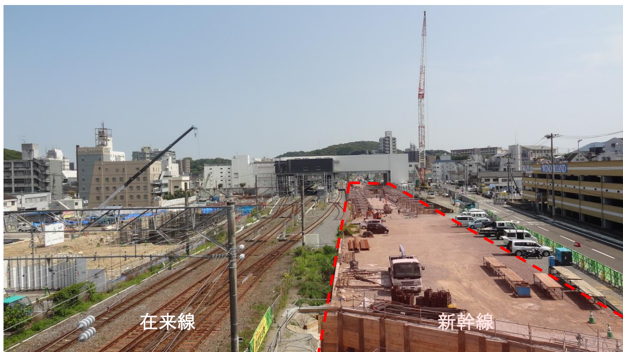
諫早駅付近の状況（諫早駅西口方面から）
