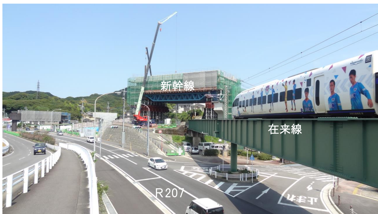
宇都橋りょう工事（諫早市宇都町付近）
