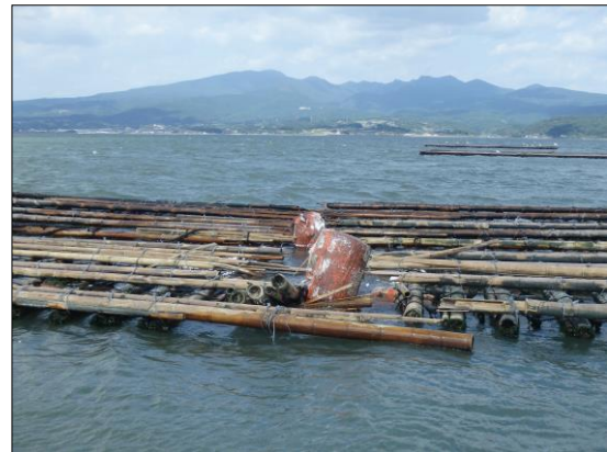
台風によるかき筏の破損状況
