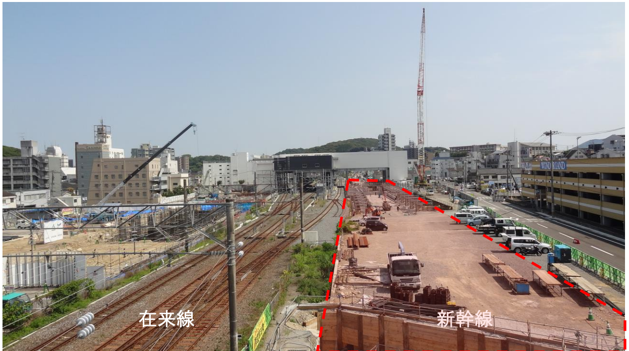
諫早駅付近の状況（諫早駅西口方面から）
