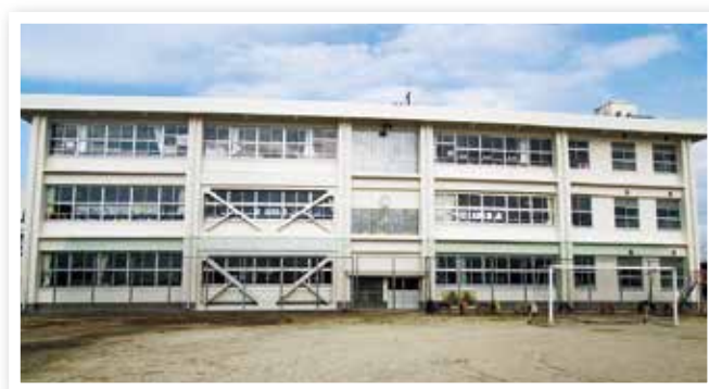
学校施設耐震補強・老朽改修事業
