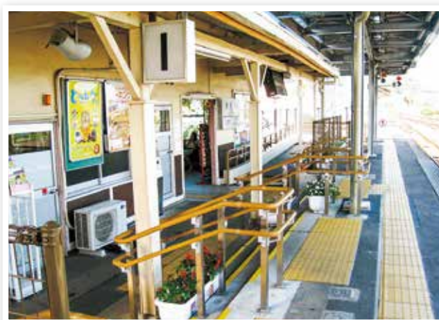
喜々津駅構内のバリアフリー化
