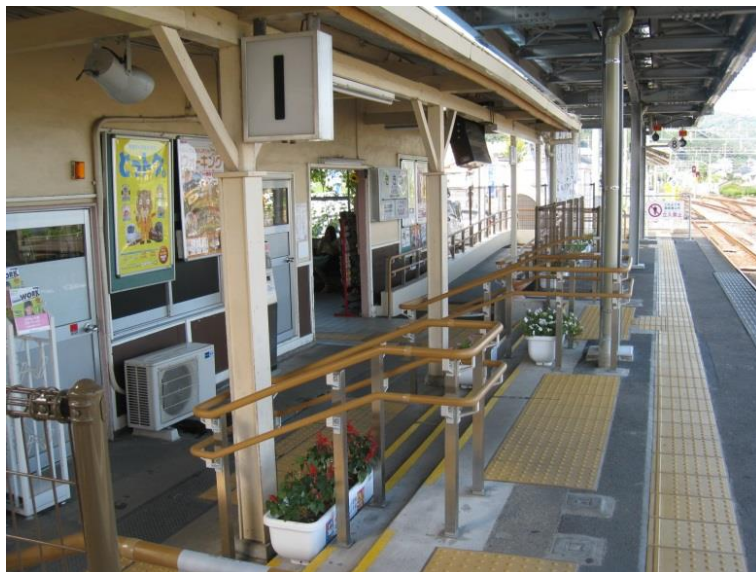
喜々津駅構内のバリアフリー
