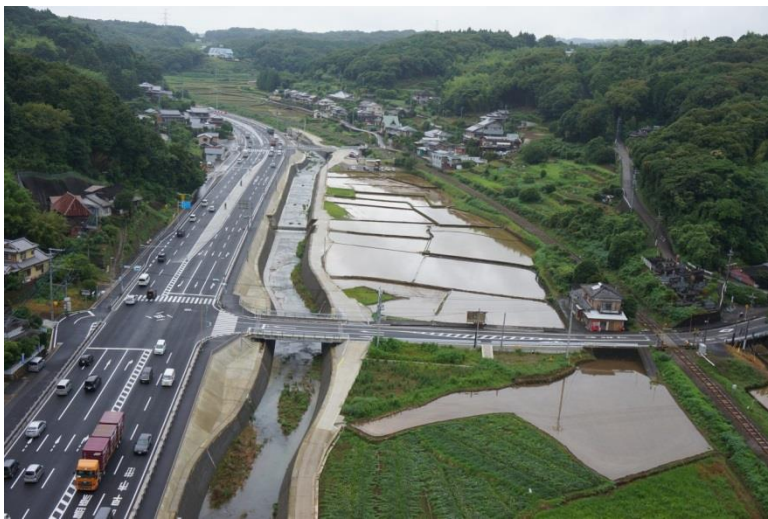
整備中の一般国道34号（本野入口交差点付近）
