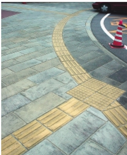
市道の点字誘導
