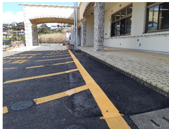
地盤沈下した建物の周囲を再舗装 (有喜ふれあい会館)
