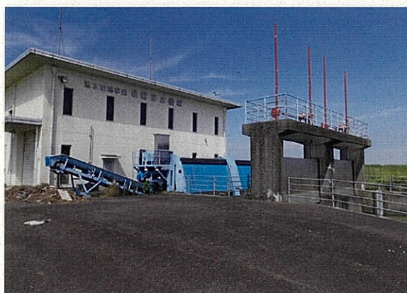
松崎排水機場(川内町)
