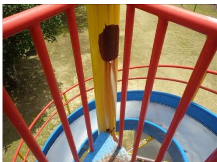
(多良見団地公園巡回滑り台腐食)
