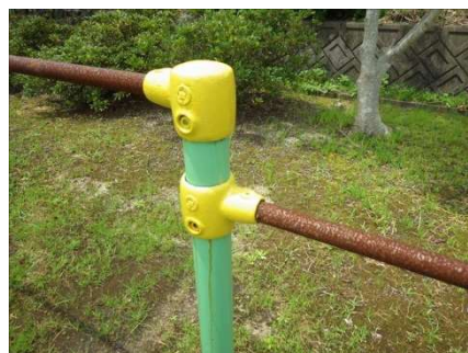
(巡川公園 3 連鉄棒腐食)
