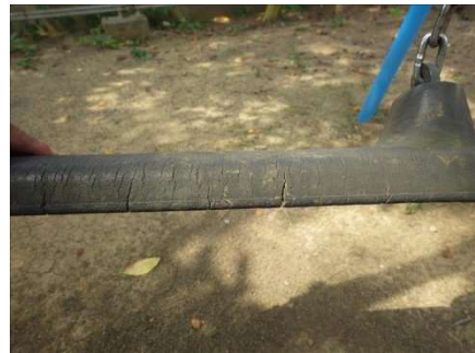
(福田町第 4 開発公園 5 連ﾌﾞﾗﾝｺ座板腐食)
