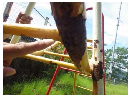
(シーサイド西公園波型ラダー腐食)
