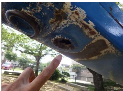
(西郷児童遊園シーソー摩耗・腐食)
