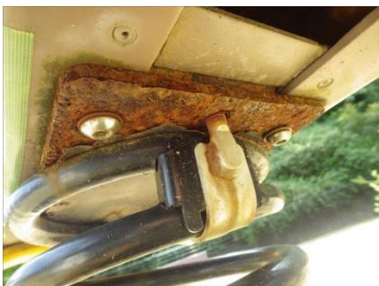
(貝津ヶ丘第 3 開発公園ｽﾌﾟﾘﾝｸﾞ 遊具台座腐食)
