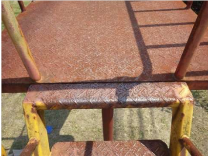
(富地戸公園滑り台床板腐食)
