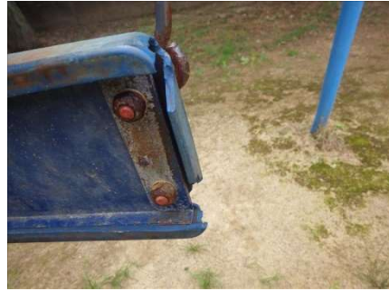
(4連ブランコ座板破損)
