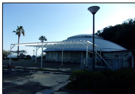
全景（入り口横駐車場側から撮影）
