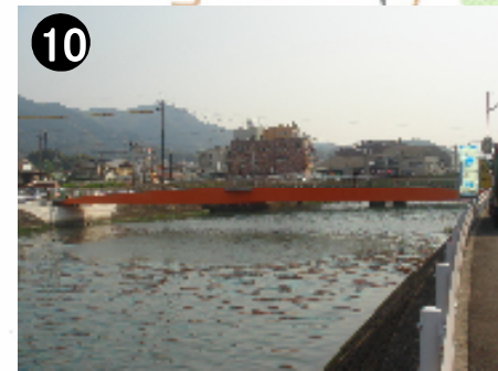
⑩ 市道化屋木床線「なごみ橋」 (平成26年4月1日 供用開始)
