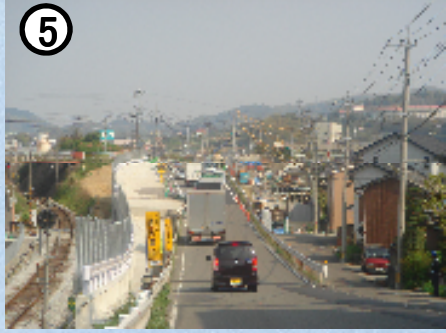
⑤ 一般国道207号【木床工区】 (交通の安全確保とその円滑化をめざします)
