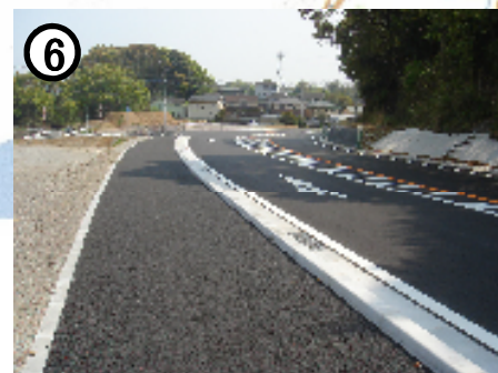
⑥ 主要地方道諫早飯盛線【新道工区】
