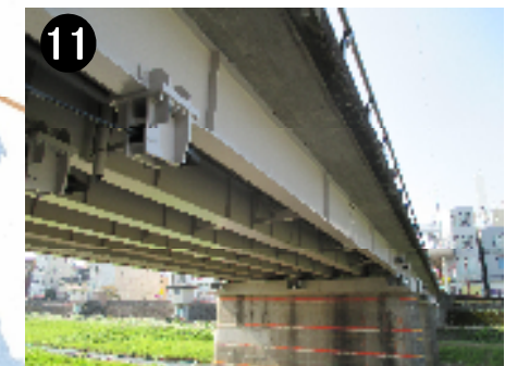
⑪ 市道八天西郷線(新橋) (橋梁の長寿命化や耐震化工事をしています)
