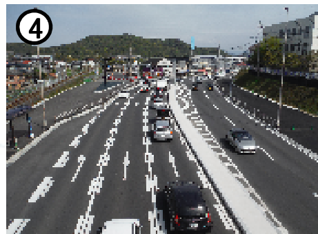
④ 一般国道57号小船越町交差点改良 (交差点のコンパクト化により交通事故の減少を目指します)
