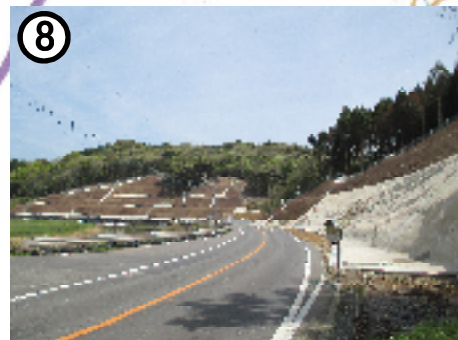
⑧ 主要地方道諫早飯盛線【土師野尾工区】
