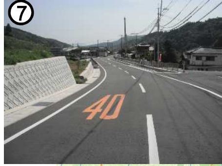
⑦ 一般県道富川溪線【富川工区】(道路拡幅)
