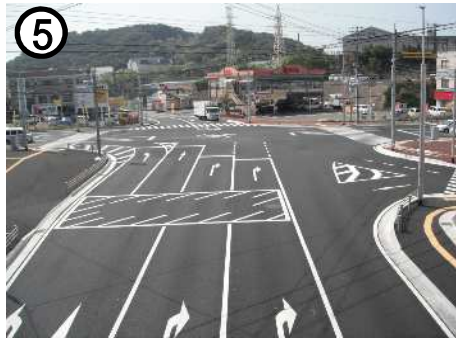
⑤ 一般国道207号【宇都工区】(交差点改良)
