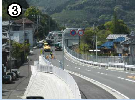
③ 一般国道207号【木床工区】(道路拡幅)
