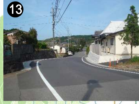
⑬ 市道田原線(道路拡幅)
