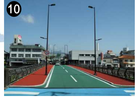
⑩ 市道八天西郷線(橋梁長寿命化)
